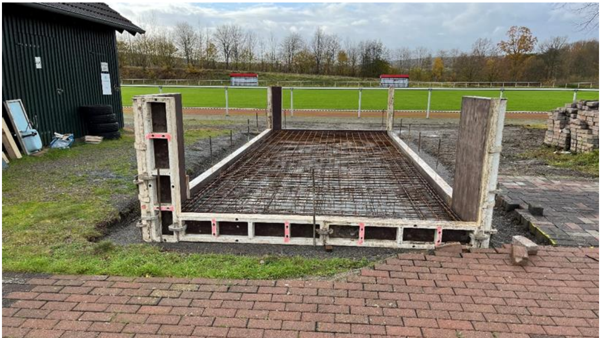
Die Schottertragschicht ist eingebaut
