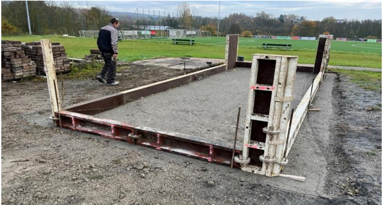
Die Schottertragschicht ist eingebaut
